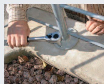
Fixation de balustrades
