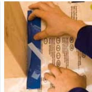
Raccord des membranes INTELLO à la maçonnerie nue :
