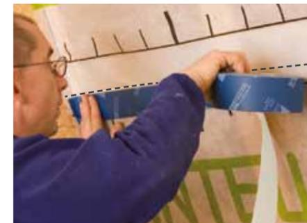
Au niveau du chevauchement, coller les membranes à l'aide du ruban adhésif TESCON No.1 ou TESCON VANA de manière à ce qu'il ne subisse aucune traction ni charge. Les plis au niveau du chevauchement ne peuvent pas être collés, mais doivent d'abord être coupés et aplanis avant
