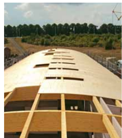
Exemple de construction: la sous-toiture en porte-à-faux de cette construction industrielle est extrêmement solide.
