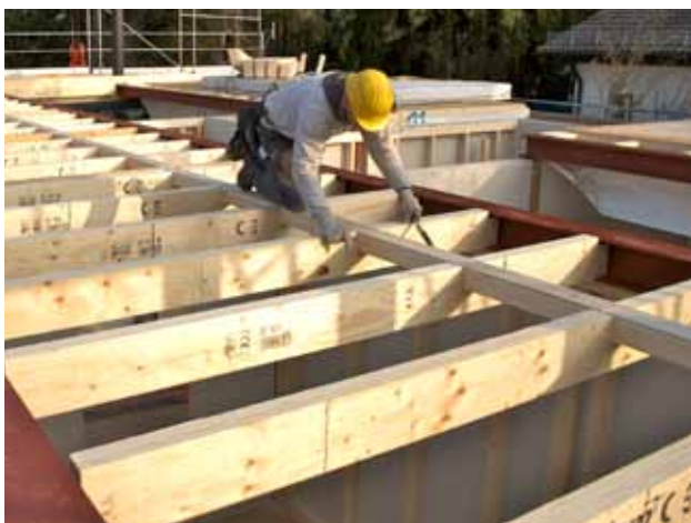
Construction de structure porteuse de plafond avec STEICO LVL R.
