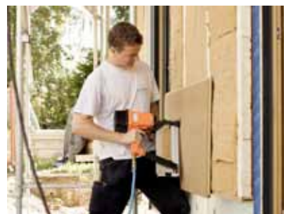
Isolation des caissons de mur avec STEICO flex . Recouvrement avec STEICO universal en tant que pare-pluie derrière la façade ventilée.
