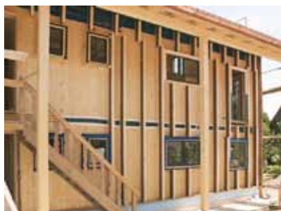
Isolation thermique par l'extérieur avec ossature secondaire STEICO wall .
