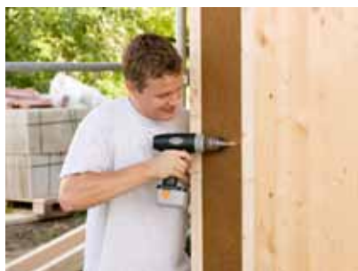
Fixation de poutres STEICO wall à travers la membrure avec des vis à bois.
